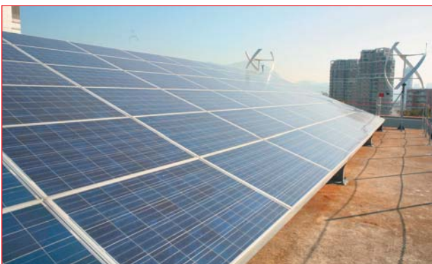
Китай, Гонконг, районный госпиталь
